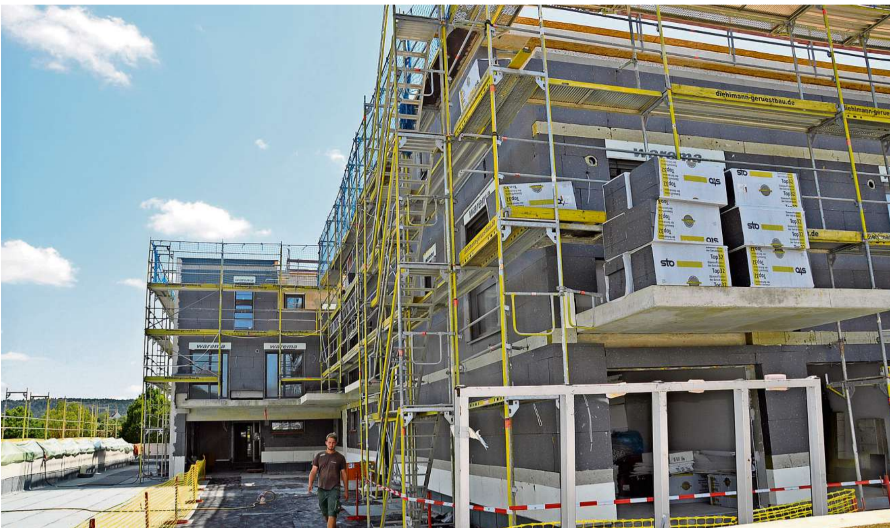
Hier wandelt Blumberg sein Gesicht: Der Eingangsbereich des im Bau befindlichen „Blumberg Quartiers“ von der Tevesstraße aus wird inklusive der Carports mit großzügigen Flächen ausgestattet. In etwa einem halben Jahr sollen die ersten Bewohner einziehen können.
