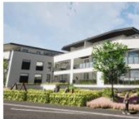
Eine Ansicht: So sollen die Neubauten einmal aussehen. BILD: ACTIV GROUP
