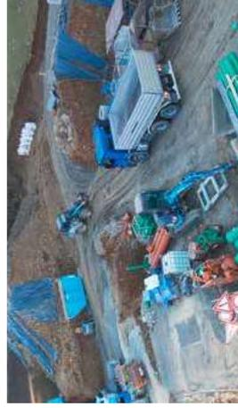
Die Bodenplatte ist bereits betoniert, die Hochbaumaßnahmen sind gestartet. Vereinzelte Erdbau- und Entwässerungsarbeiten sind noch nicht gänzlich abgeschlossen.
