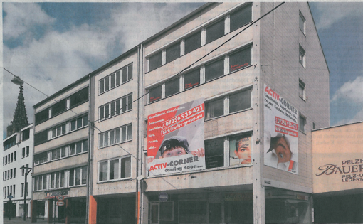
Keine Zukunft: Die leer stehende Geschäftshaus-Immobilie an der Ecke Neue Straße/Frauenstraße.
