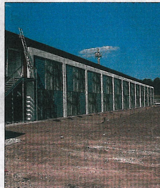
... die Netzmembranfassade und die unsichtbare Photovoltaikanlage ...
