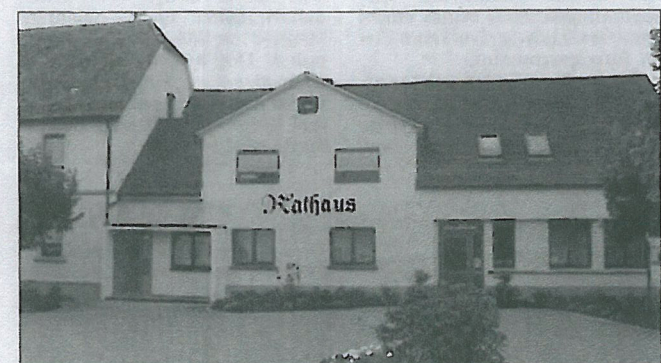
Das als Teil des Dischinger Rathauses genutzte Haus Bairle gegenüber dem eigentlichen Verwaltungssitz der Gemeinde in der Ortsmitte: An seinem Standort soll bis in ein paar Jahren ein neu zu errichtendes Rathaus für die Härtsfeldgemeinde stehen. Foto: dam
