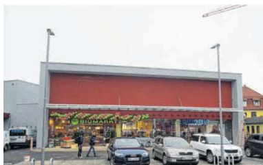
Für die Kunden stehen insgesamt 120 Parkplätze zur Verfügung.
