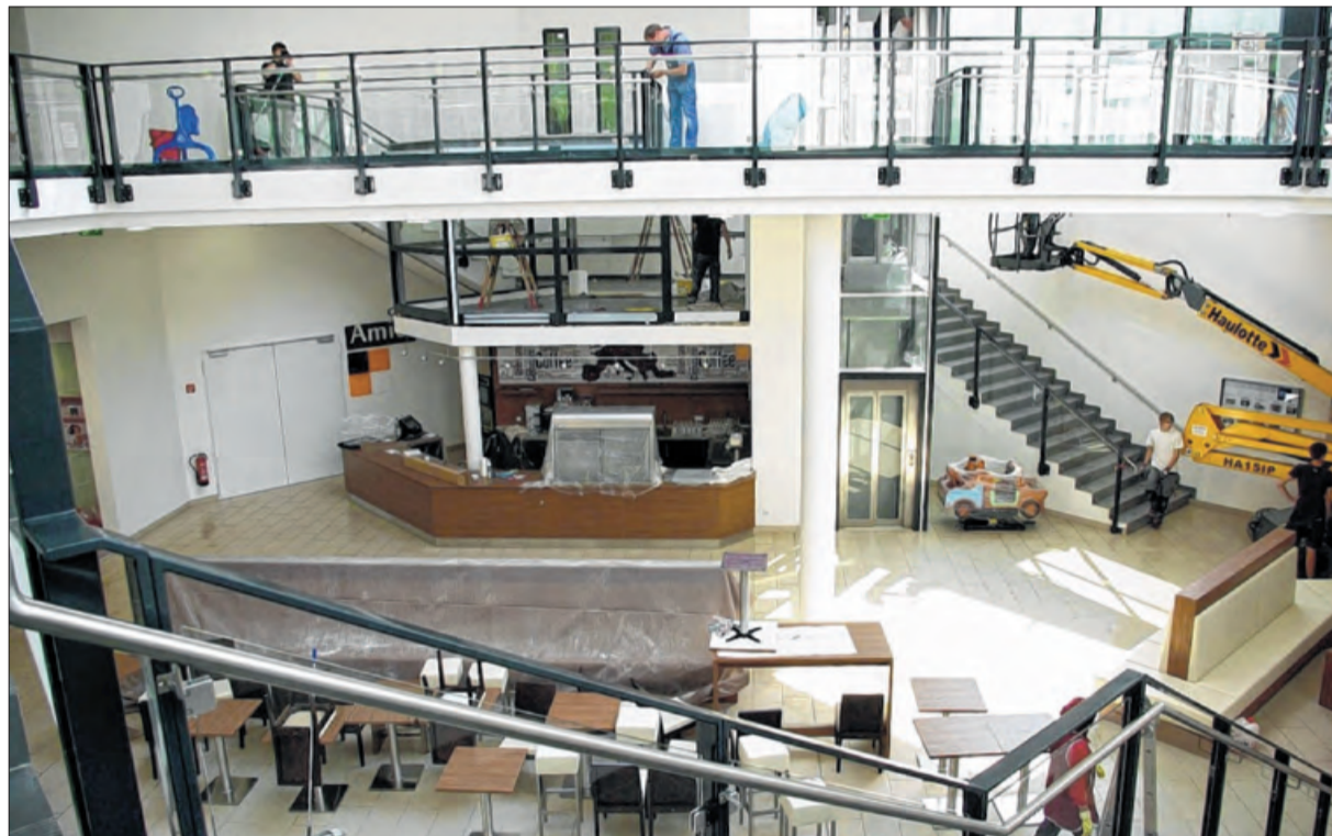
Einen Tag vor der Eröffnung der Mall wird noch an allen Ecken und Kanten Hand angelegt.
