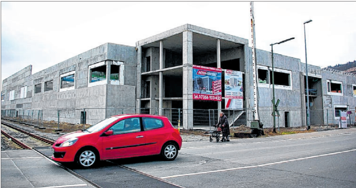
104 Meter lang und 73 Meter breit ist das Einkaufszentrum, das am Bahnhof gebaut wird.
