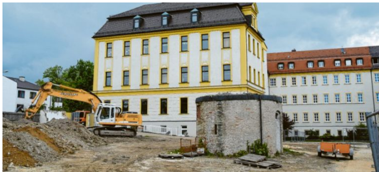
Hier in der Erzbischof-Stimpfle-Straße bauen die Regens-Wagner-Stiftungen ein neues Bürogebäude. Das Verwaltungsgebäude wird voraussichtlich rund 15 Millionen Euro kosten, es dürfte das Stadtbild prägen.
