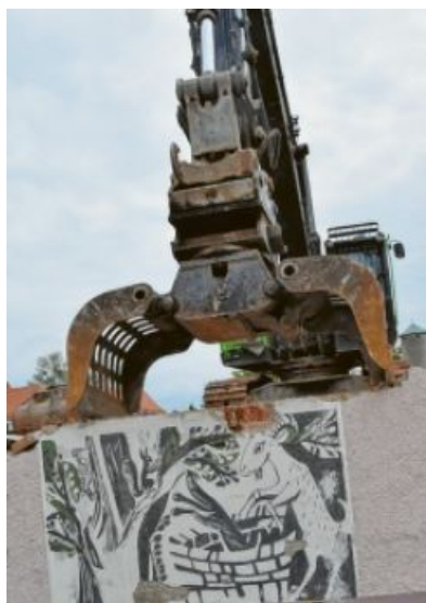
Beim Abbruch des einstigen Kindergartens bleibt das Gemälde auf der Strecke.
