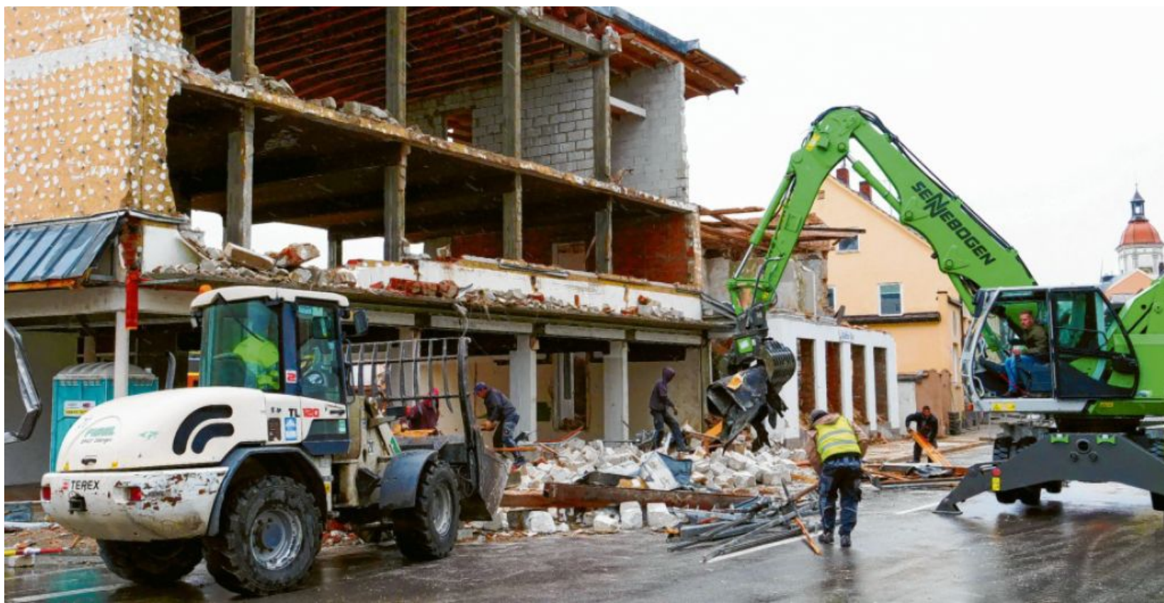
Die Kapuzinerstraße musste am Samstagmittag wegen der Abbrucharbeiten voll gesperrt werden.
