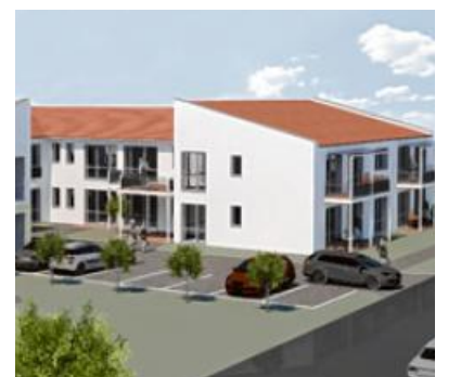
Am Hofweierweg in Dillingen baut die Lebenshilfe ein Wohnheim für Menschen mit Autismus. 16 Plätze werden entstehen. Die einstige Krankenhauswäscherei wird abgerissen. Foto: Lebenshilfe
