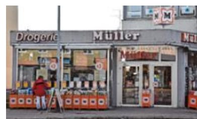
Der Drogeriemarkt Müller ist bisher im Gebäude Kapuzinerstraße 17 untergebracht.
